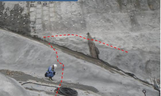
法面頂部の平場に開口亀裂
