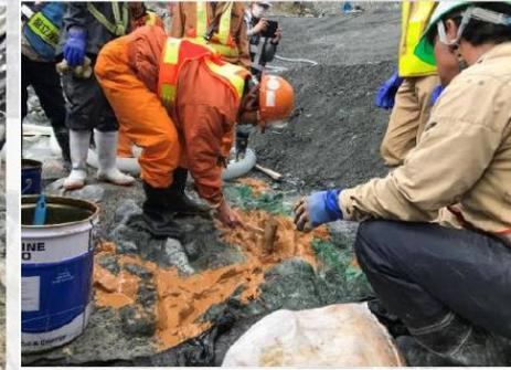
④エアタンパによる着岩材締固め
